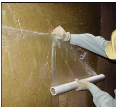
マスカー処理
