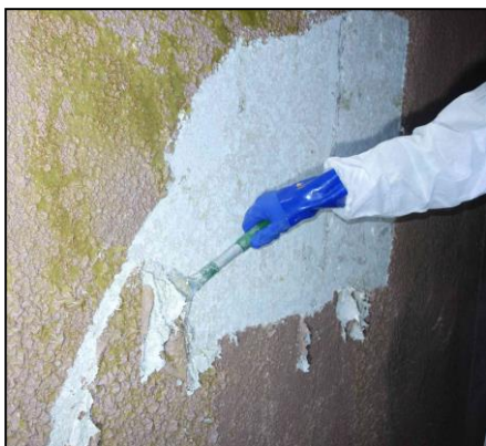
スクレーパーで剥離
