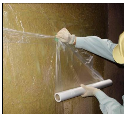
マスカー処理
